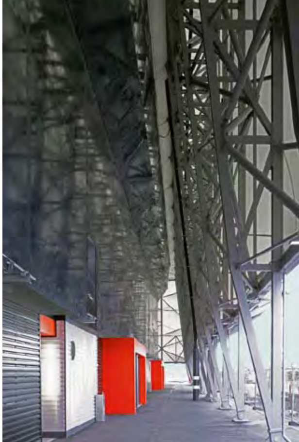
Haus-in-Haus-Konzept mit Stahlgerüst
