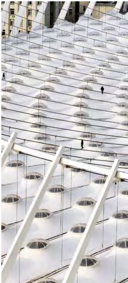
Das Membrandach wird von zwei Seilebenen getragen. Es ist aufgeteilt in 40 Membranfelder mit insgesamt 640 unterspannten Hochpunkten mit Lichtkuppeln
