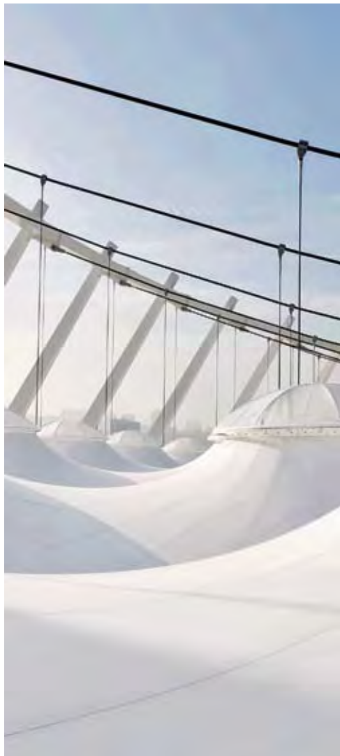
Das Membrandach wird von zwei Seilebenen getragen. Es ist aufgeteilt in 40 Membranfelder mit insgesamt 640 unterspannten Hochpunkten mit Lichtkuppeln
